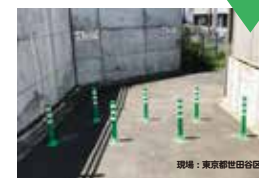
現場：東京都世田谷区
