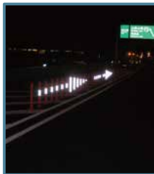
逆走防止対策 夜には矢印型の反射シートが反射 して進行方向が明確に分かります。
