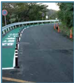
歩者分離対策・転落防止対策 舗装とポストの設置によって 区分が分かりやすいですね。
